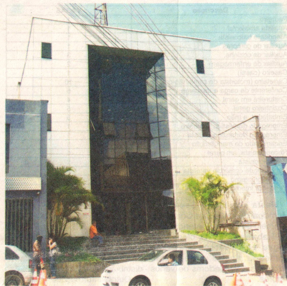
Novo prédio para a realização dos serviços da Secretaria de Educação, na Rua XV de Novembro
