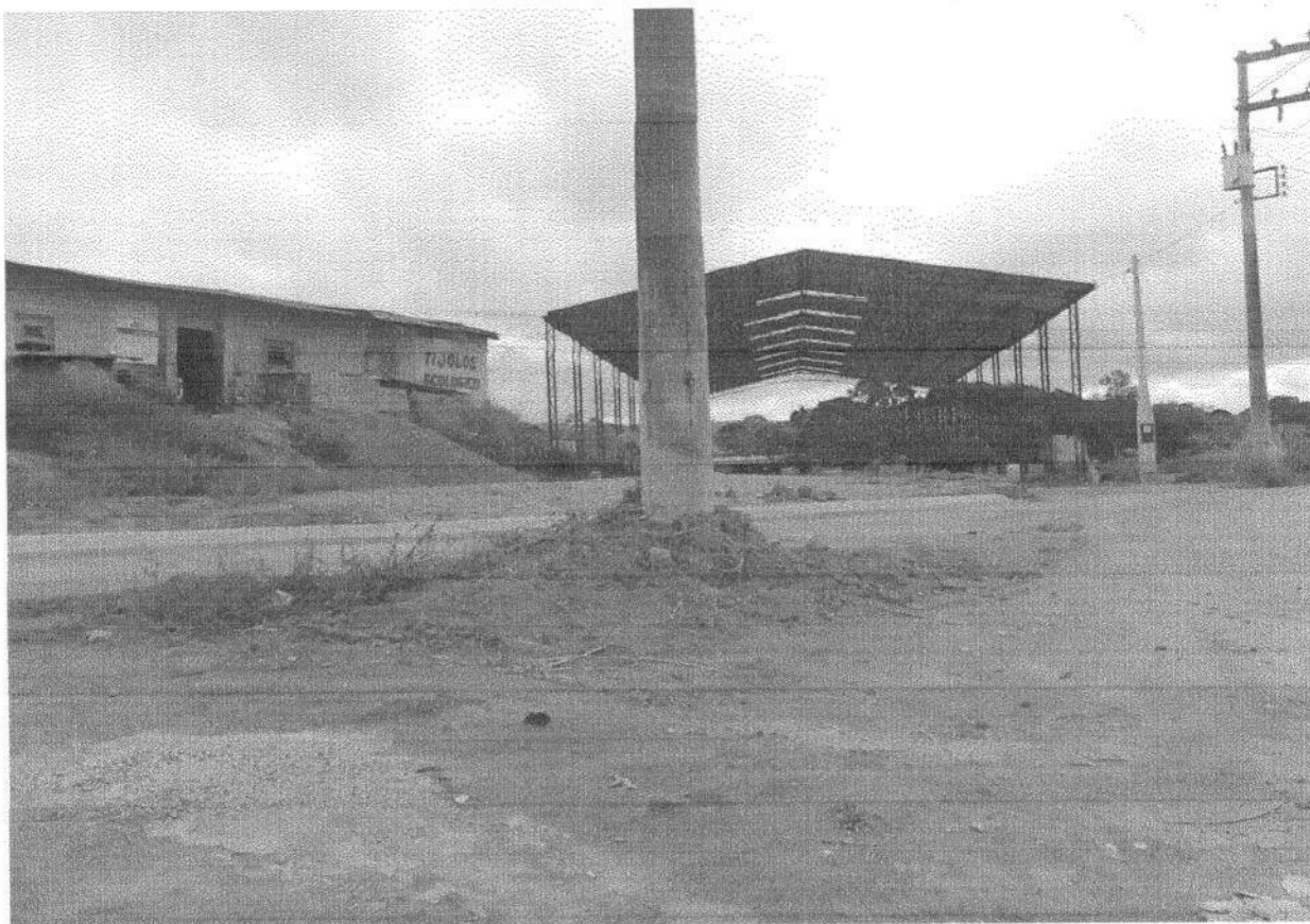
Há construção preexistente – observe-se o concreto recente que demonstra que as guias foram colocadas recentemente – foto de 17 de abril de 2012
