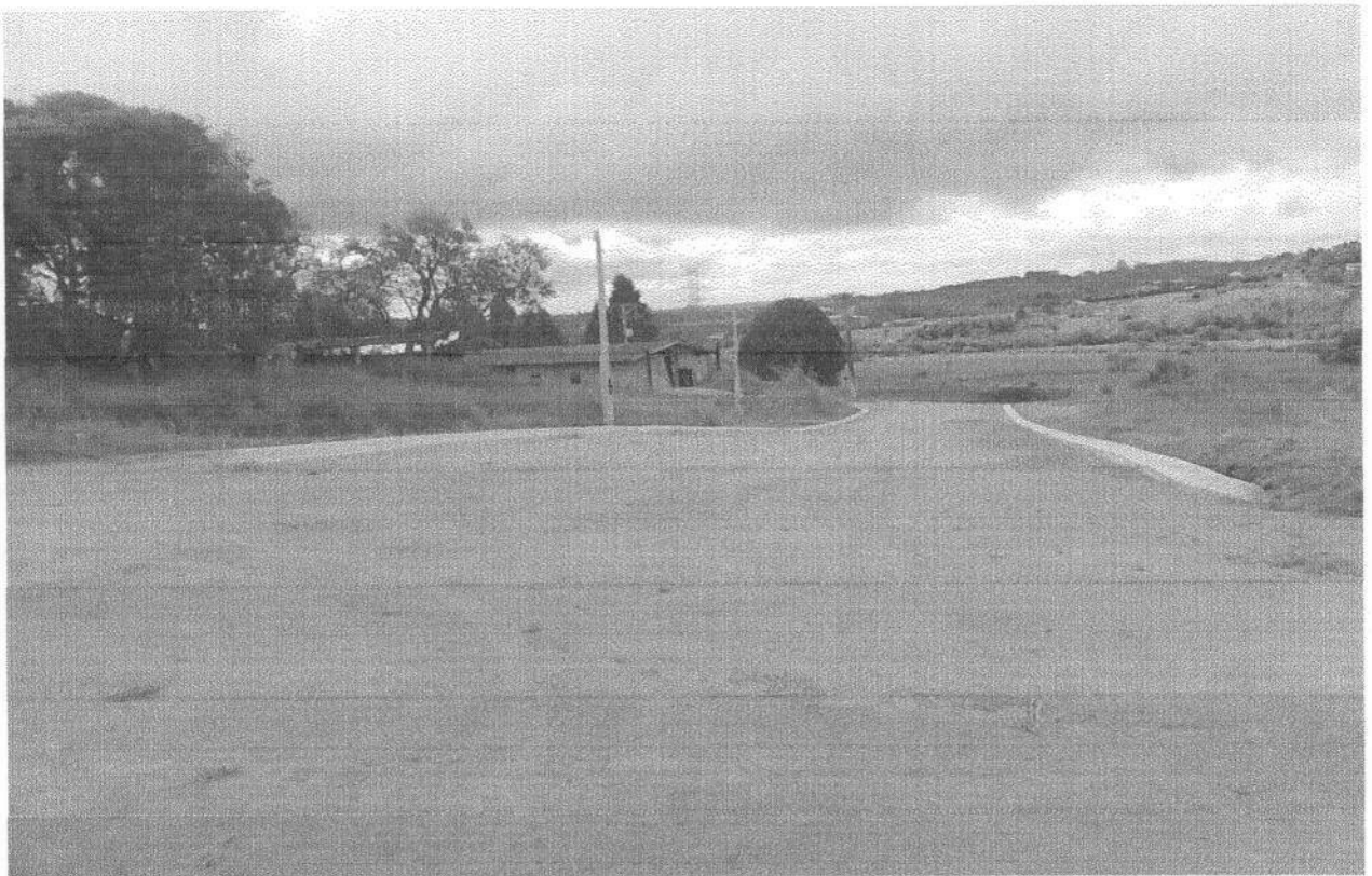
Guias colocadas recentemente – foto de 17 de abril de 2012
