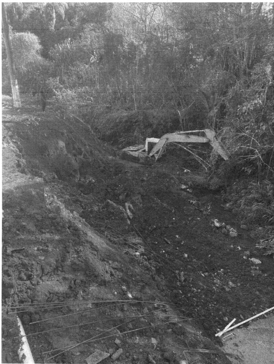
Foto 6 – Atolamento do maquinário
