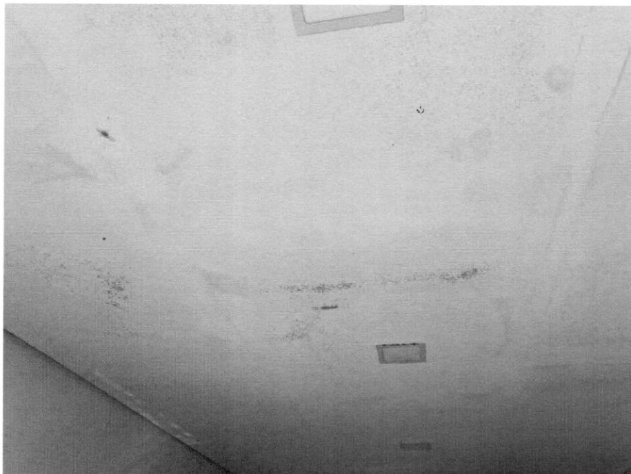
Foto 28 - Infiltrações existentes
