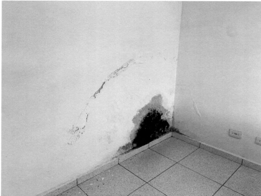
Foto 15 - Infiltrações existentes
