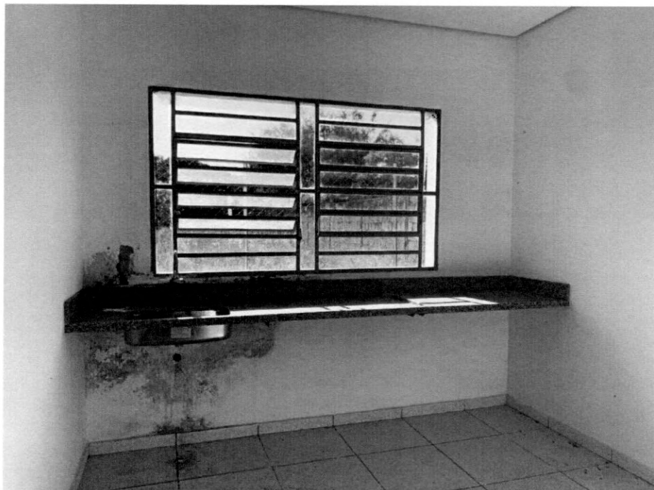
Foto 32 - Infiltrações existentes
