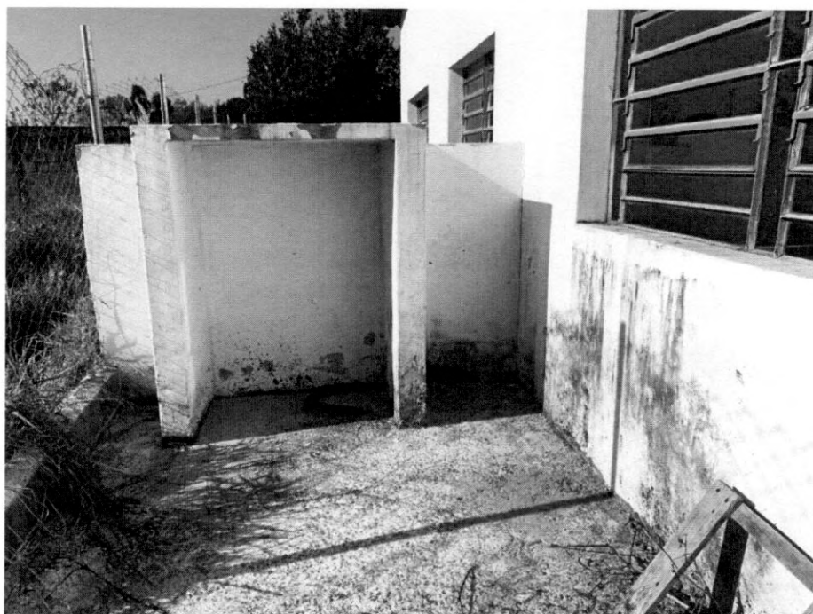
Foto 29 - Infiltrações existentes
