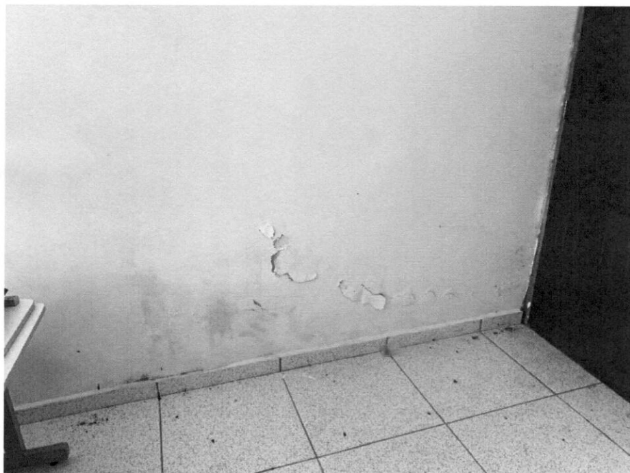
Foto 9 - Infiltrações existentes
