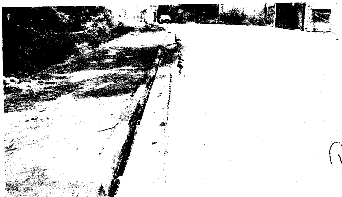
Foto nº 1 – Deslocamento de talude, registro fotográfico 06/02/2020
