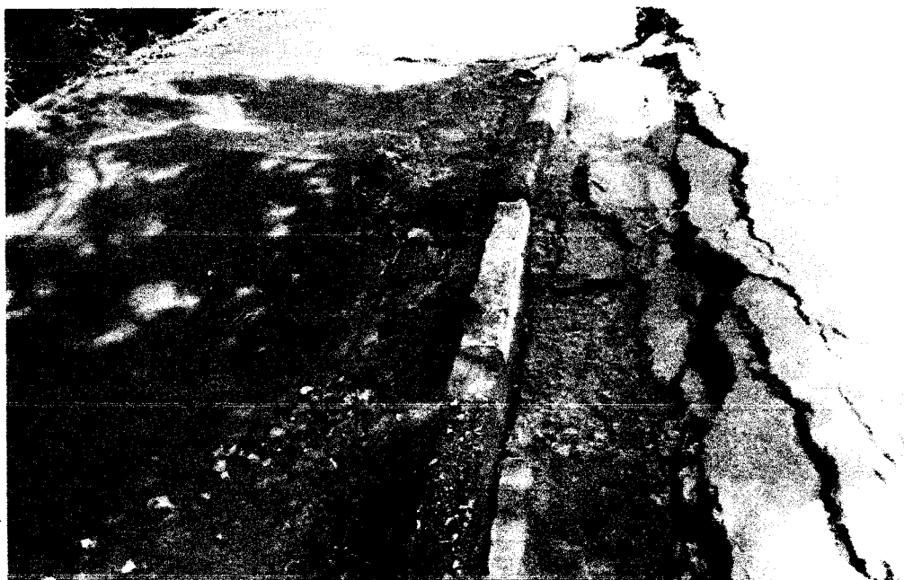
Foto nº 4 – Deslocamento de talude, rebaixamento de guia e sarjeta e rompimento do pavimento, registro fotográfico 06/02/2020
