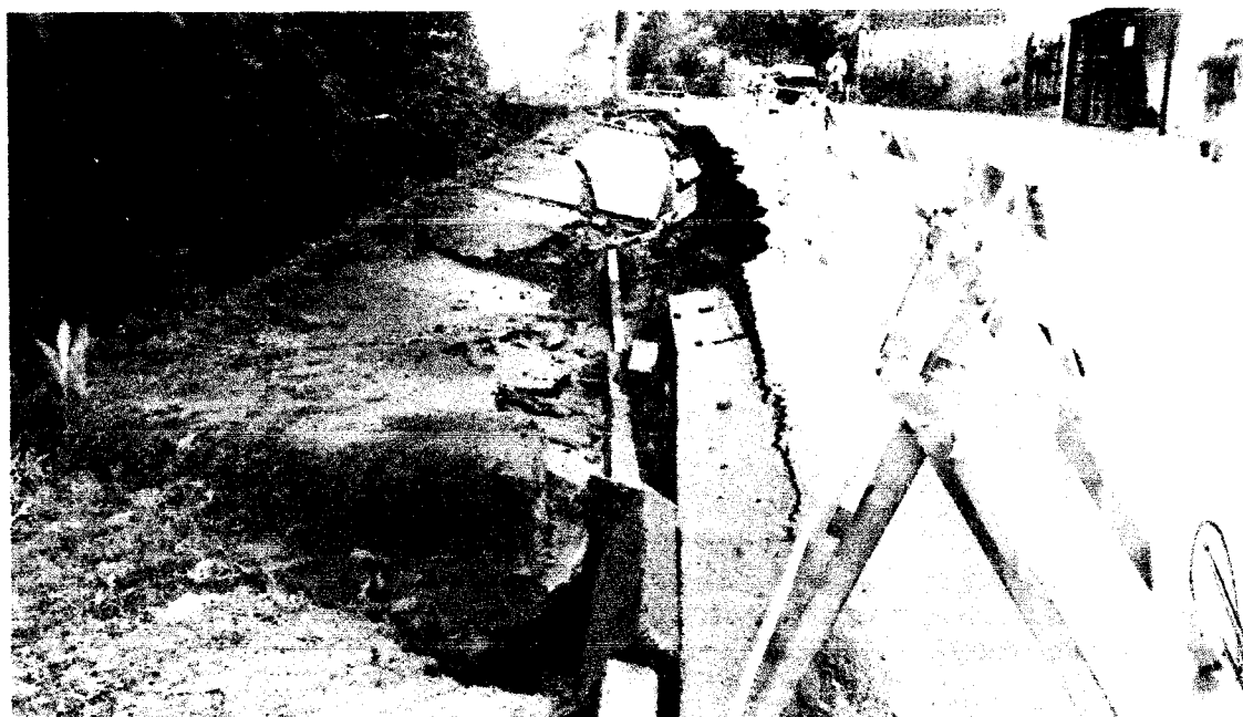
Foto nº 5 – Vista da situação atual, apresentando recalque acentuado do muro de arrimo e calçada, registro fotográfico 10/02/2020
