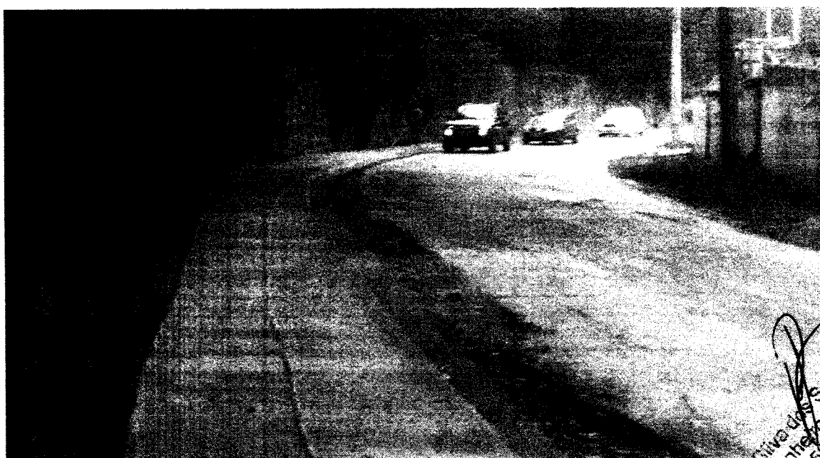
Foto nº 04 – Preparação do Trecho após a ponte, ora concluída.
