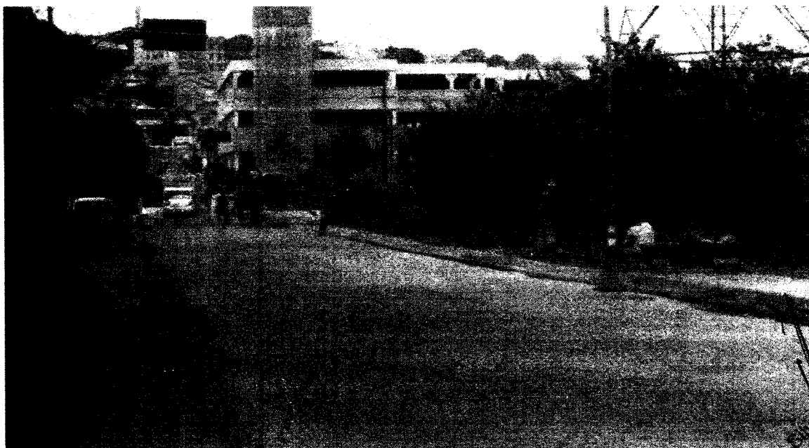
Foto nº 03 – Preparação do Trecho após a ponte, ora concluída.
