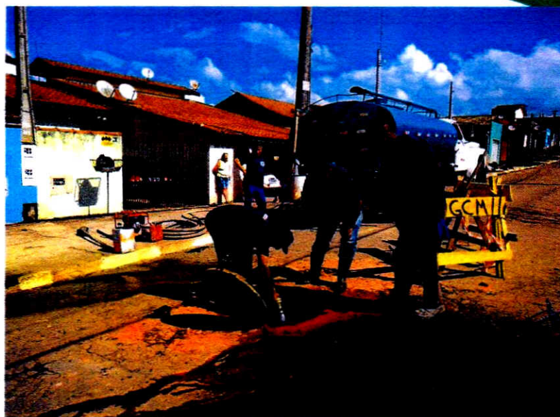
Foto 2 – Limpeza da linha de drenagem
