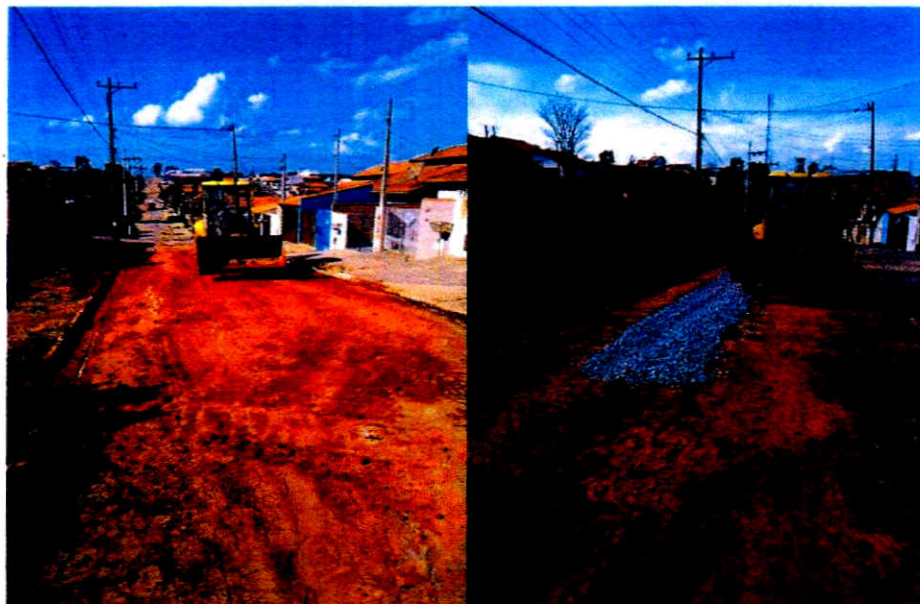
Foto 4— Fechamento da vala e recomposição provisório do pavimento
