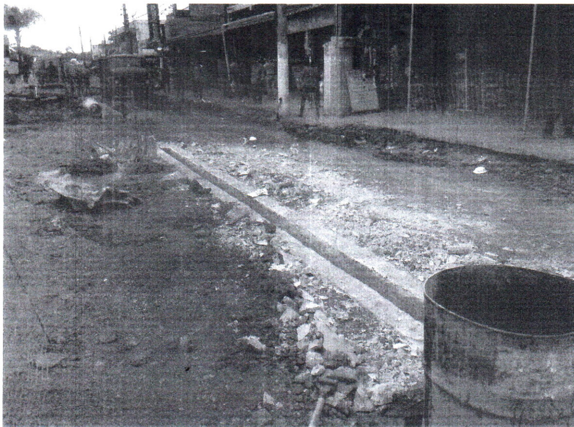
FOTO 20 – Início da instalação da grelha. Data: 20/06/2016
