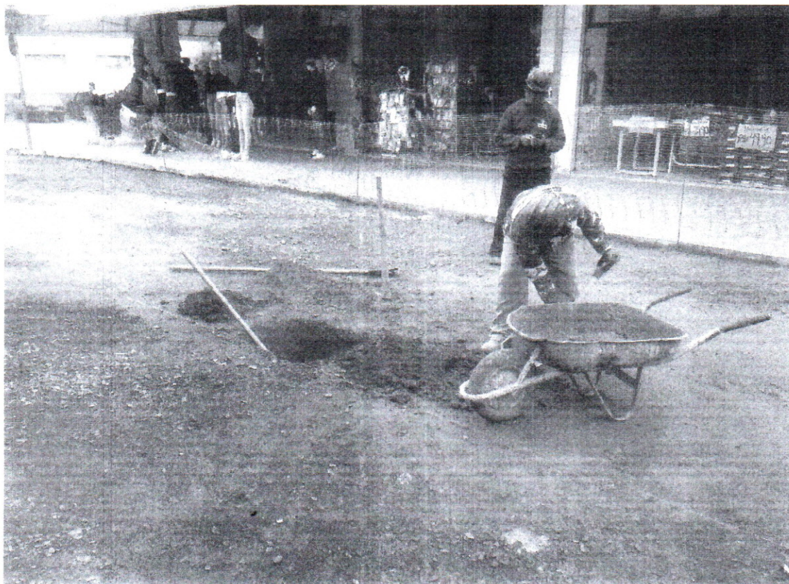
FOTO 26 – Início da instalação das caixas de luz. Data: 21/06/2016
