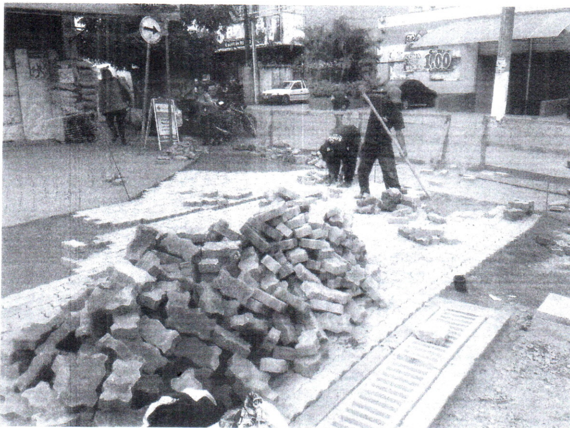
FOTO 31 – Início da instalação do intertravado. Data: 22/06/2016
