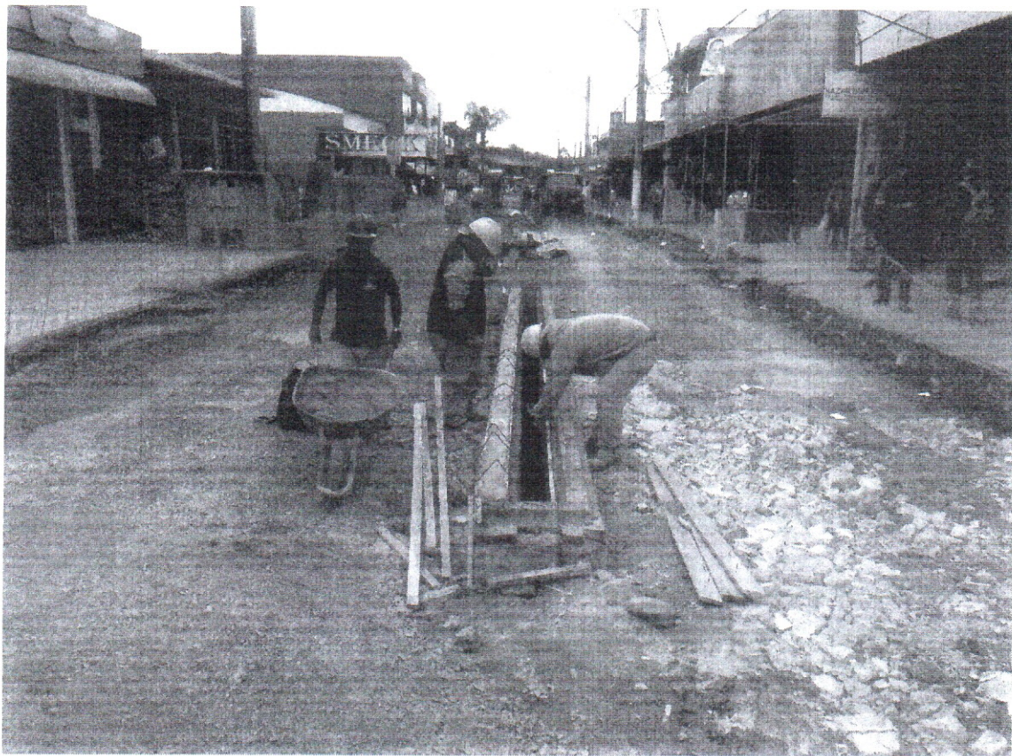
FOTO 17 – Instalação da grelha. Data: 20/06/2016
