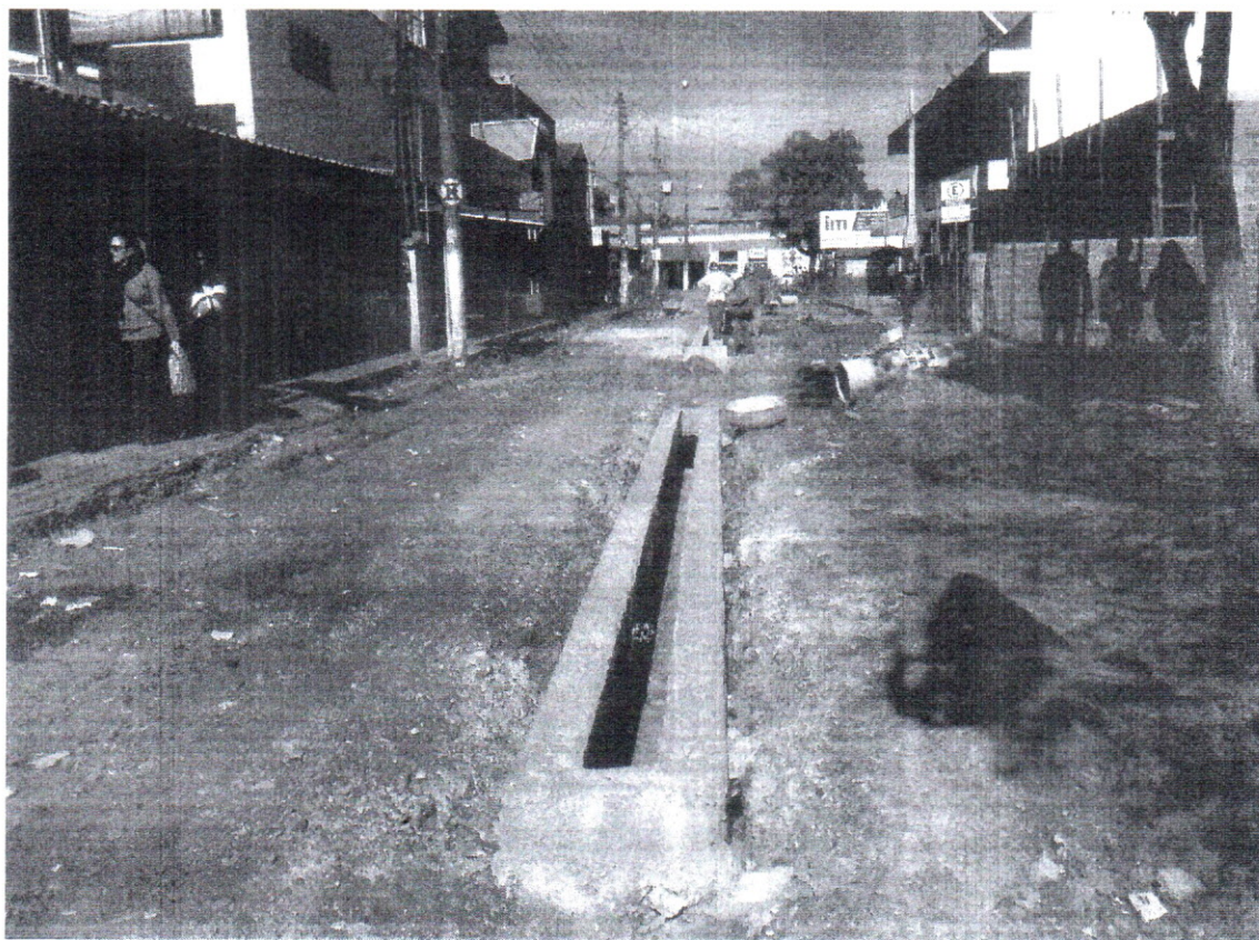
FOTO 10 – Início da instalação da grelha. Data: 14/06/2016
