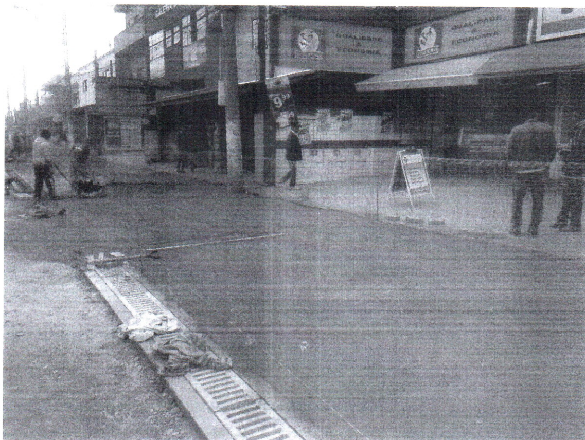
FOTO 32 – Instalação da grelha. E preparação do solo para a instalação do intertravado. Data: 22/06/2016
