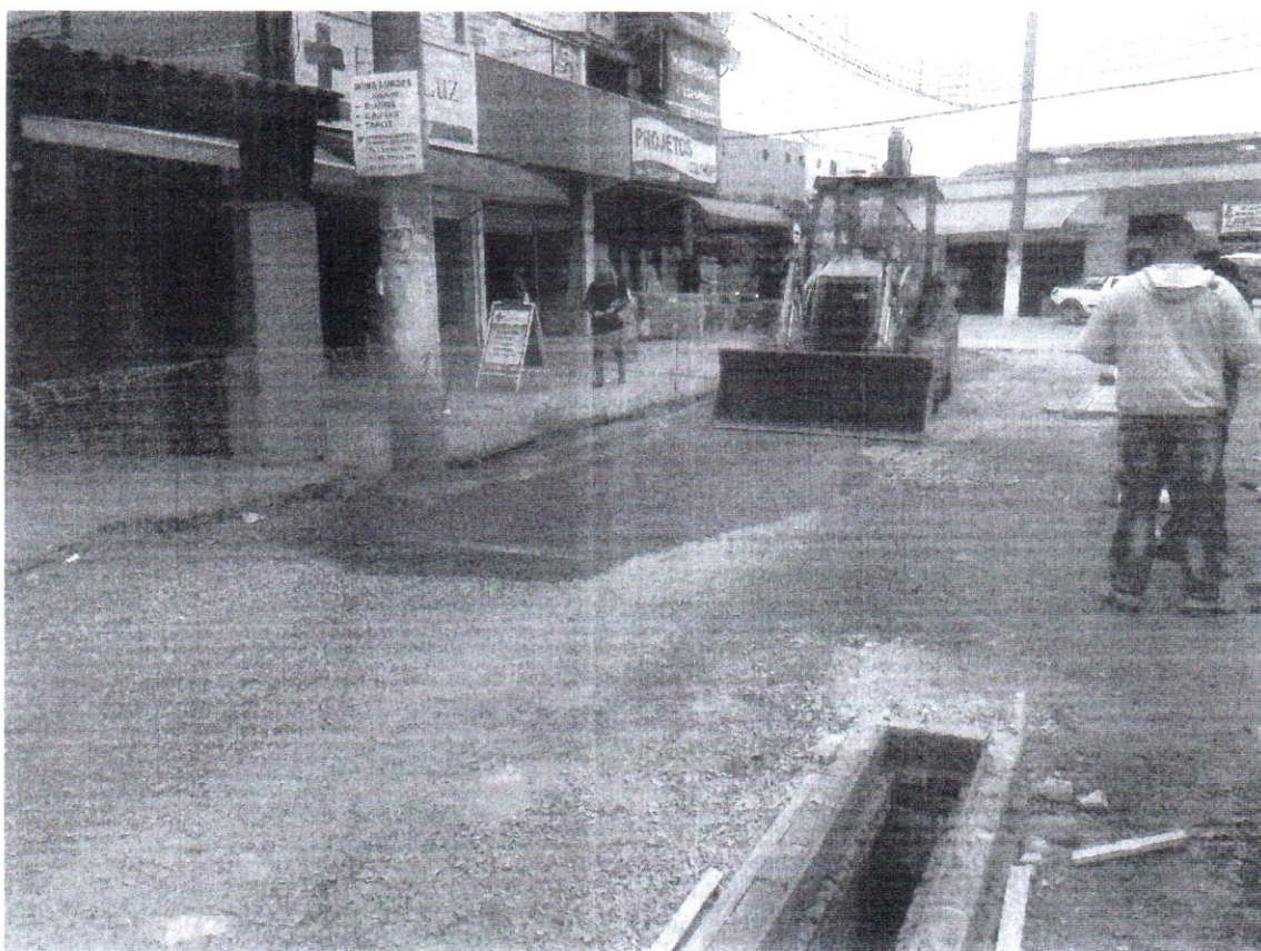
FOTO 29 - Preparações do solo para a instalação do intertravado. Data: 21/06/2016
