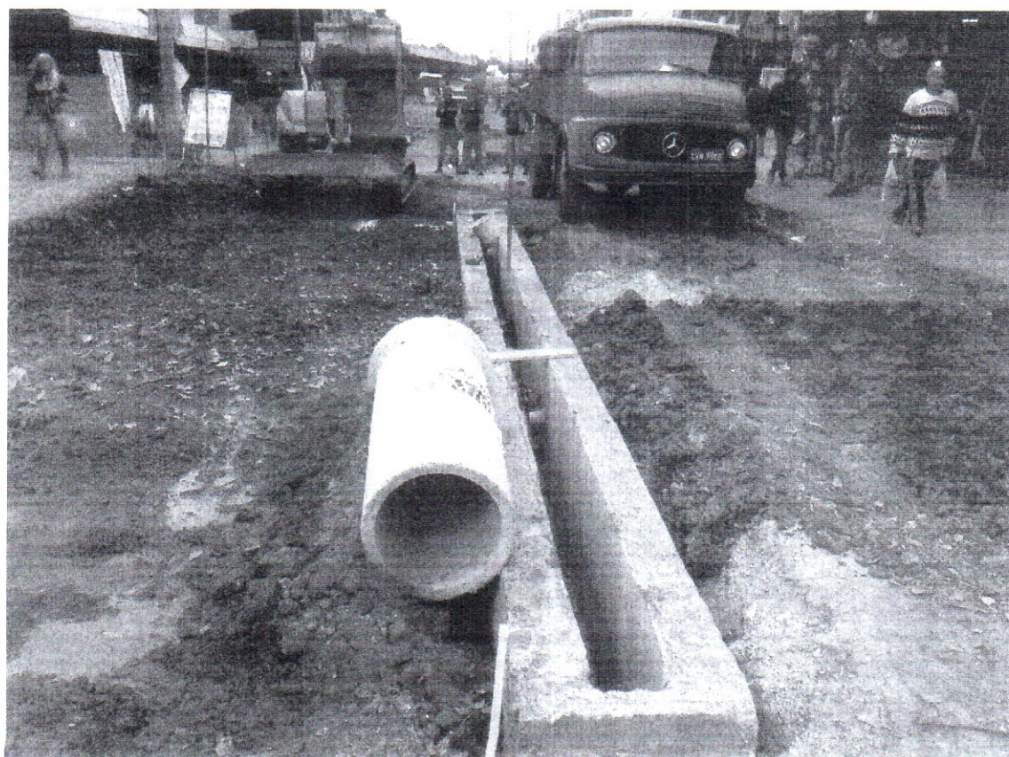
FOTO 21 – Início da instalação da grelha. Data: 20/06/2016
