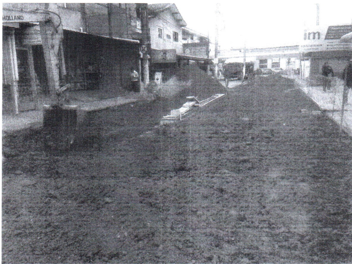
FOTO 25 – Preparação do solo para a instalação do intertravado. Data: 21/06/2016
