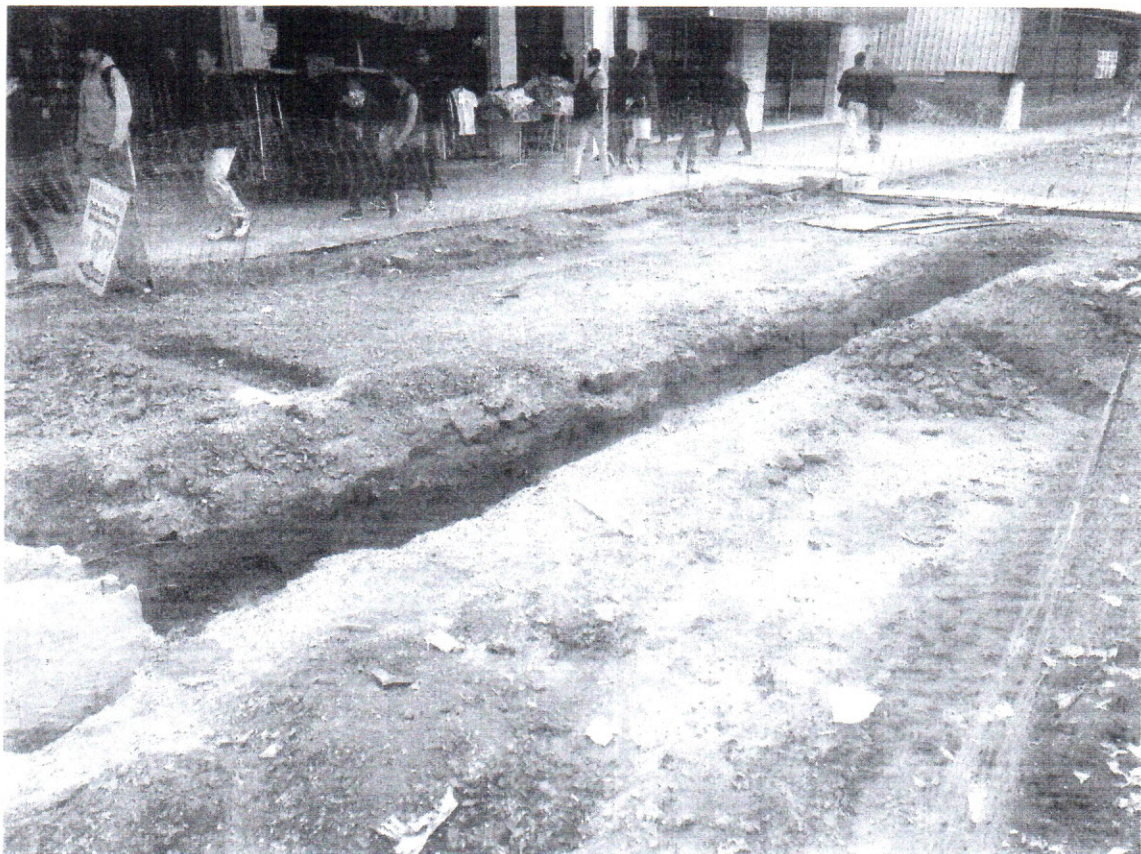
FOTO 23 – Início da instalação da grelha. Data: 20/06/2016
