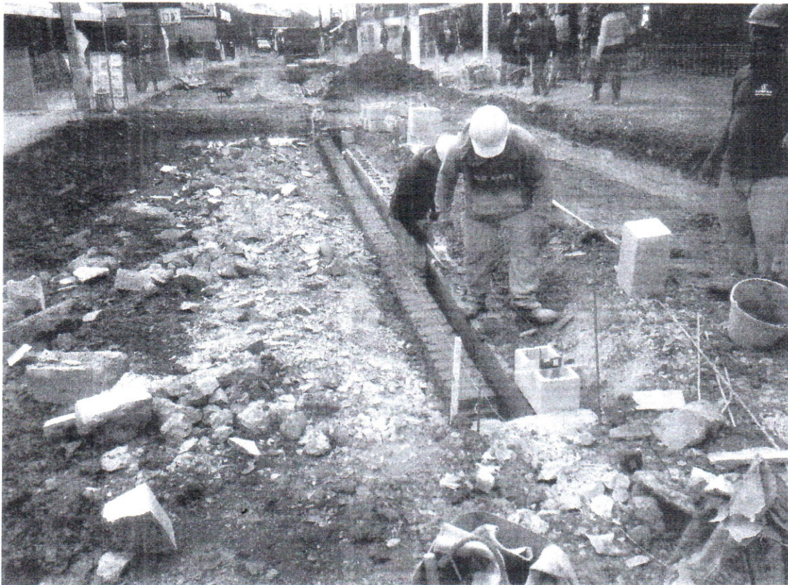
FOTO 35 – Instalação da grelha. Data: 09/06/2016
