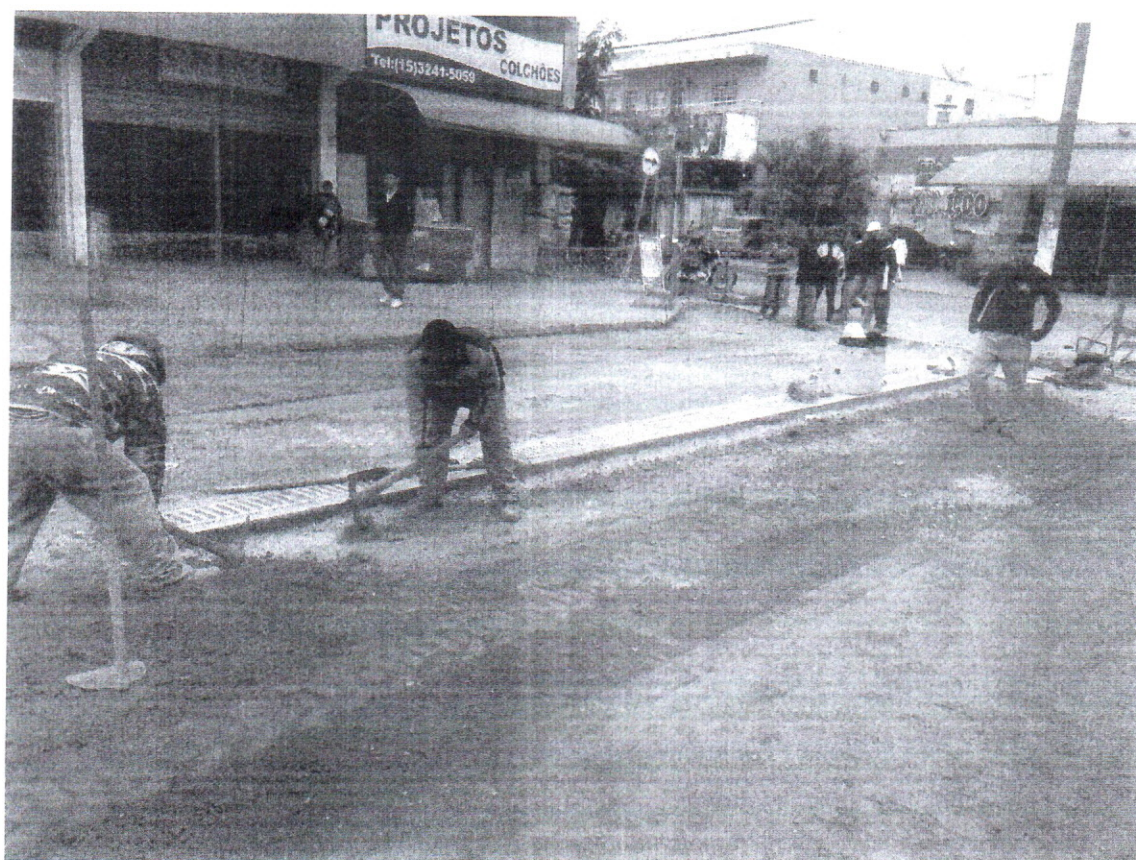
FOTO 30 - Preparações do solo para a instalação do intertravado. Data: 21/06/2016
