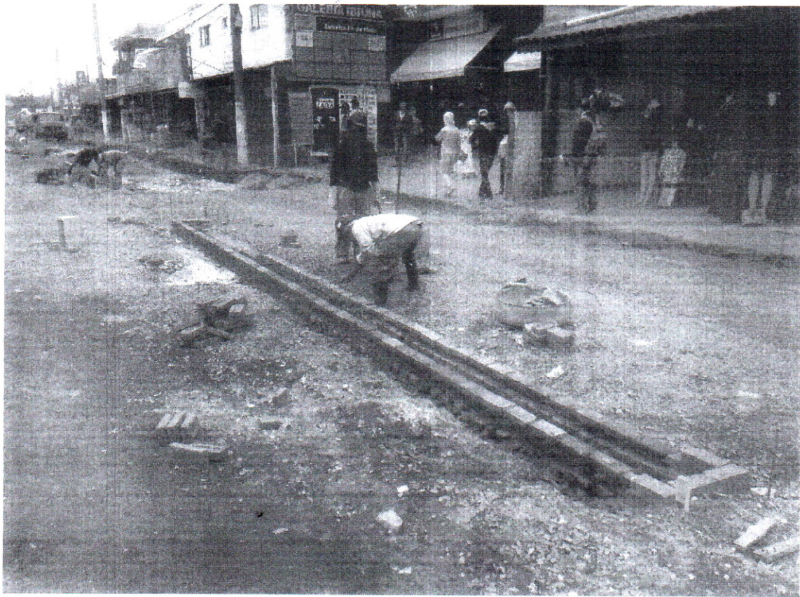
FOTO 16 – Instalação da grelha. Data: 20/06/2016
