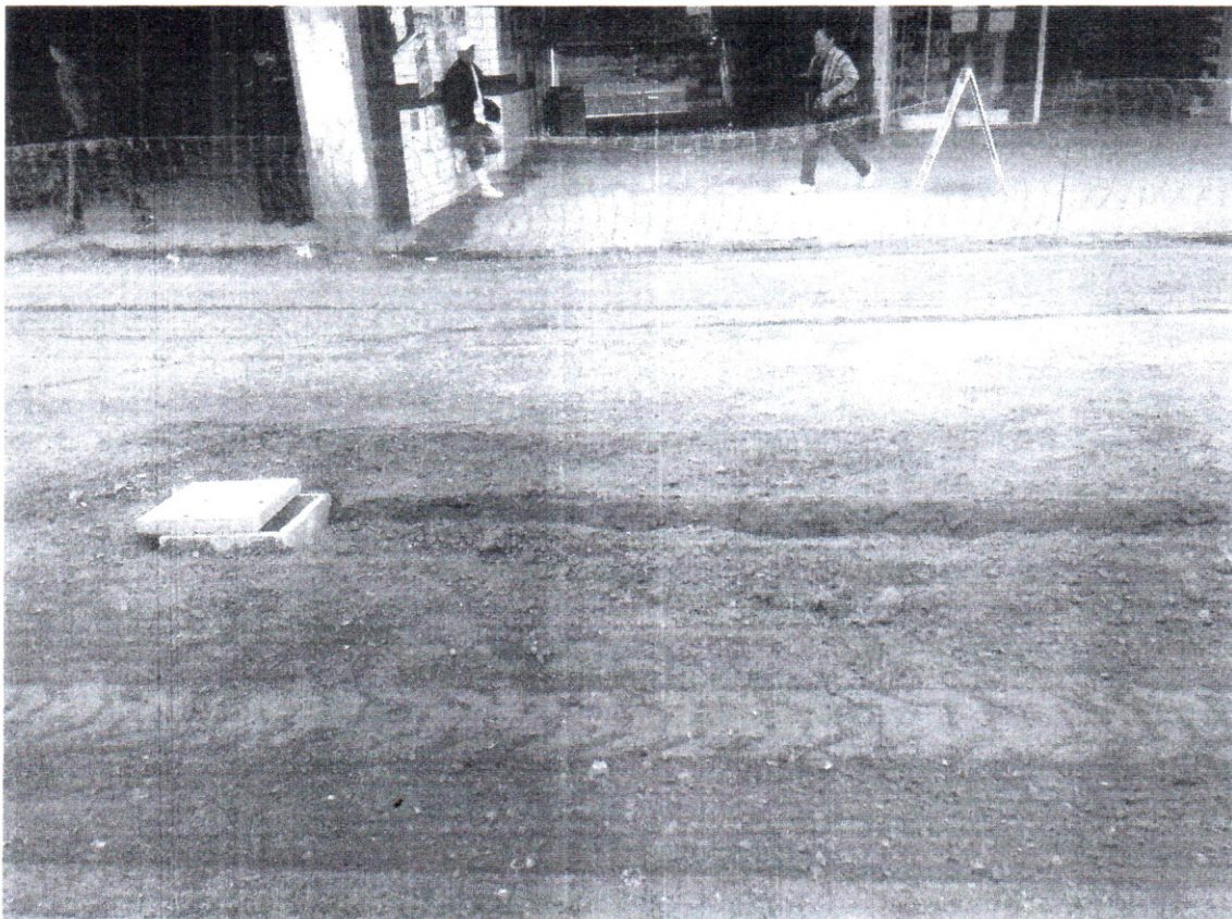
FOTO 28 – Início da instalação das caixas de luz. Data: 21/06/2016
