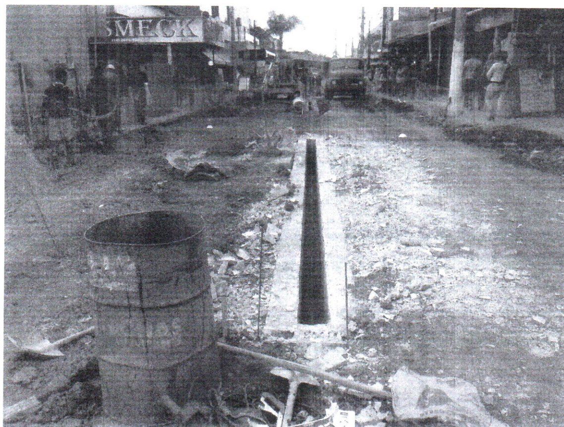
FOTO 19 – Início da instalação da grelha. Data: 20/06/2016
