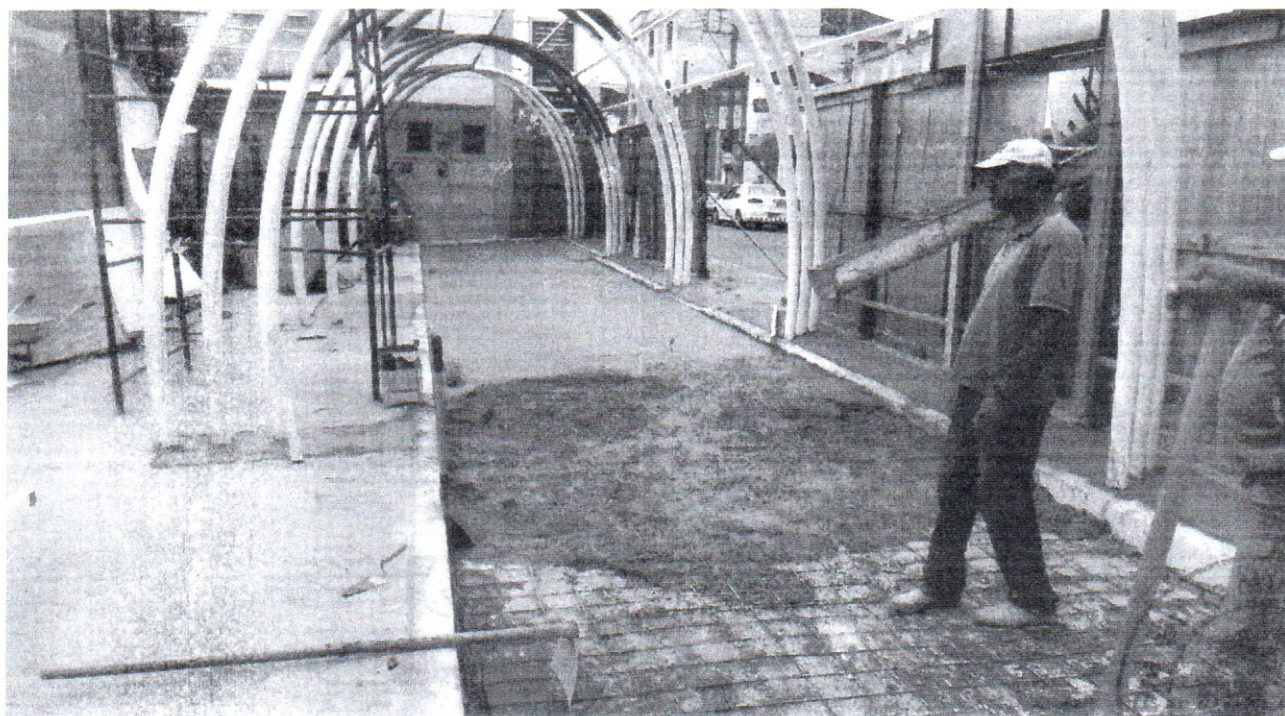
FOTO 14 – CONCRETAGEM DA BASE
